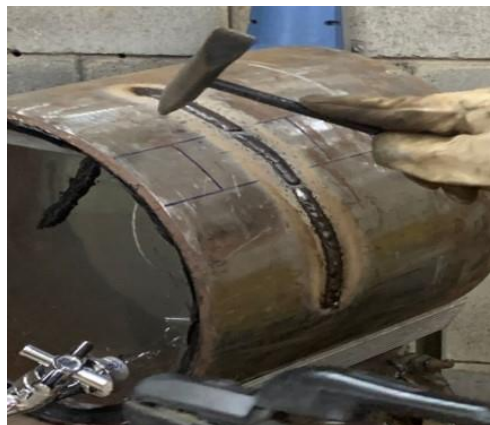
Figura 3: Primeiro passe de solda com eletrodo revestido e passagem de fluido
