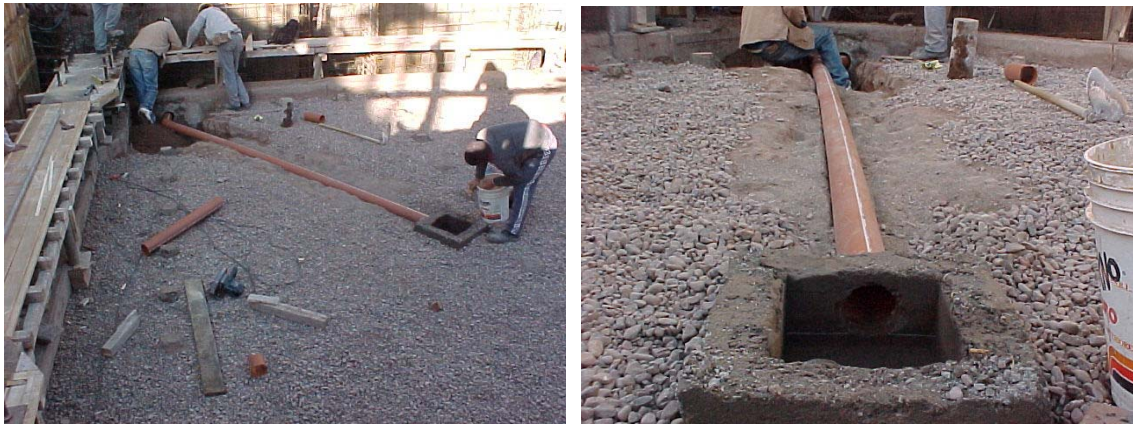
Fig. 9.8: Conducción de desagües de líquidos al pozo de absorción a nivel de piso del subsuelo
