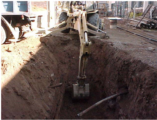
Fig. 9.1: Trabajos de excavación para alojar la estructura de fundación del edificio con aislamiento sísmico (Torre 3)
