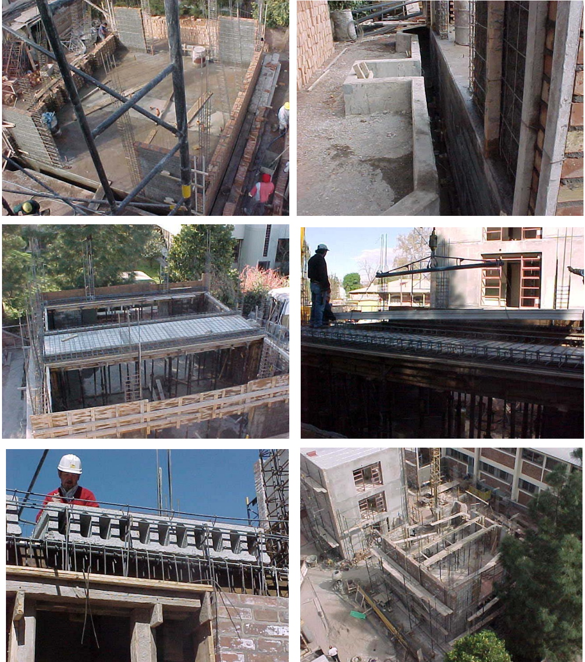
Fig. 9.11: Trabajos de mampostería, losa 1º nivel y estructura vertical de edificio con aislamiento sísmico (torre 3).
