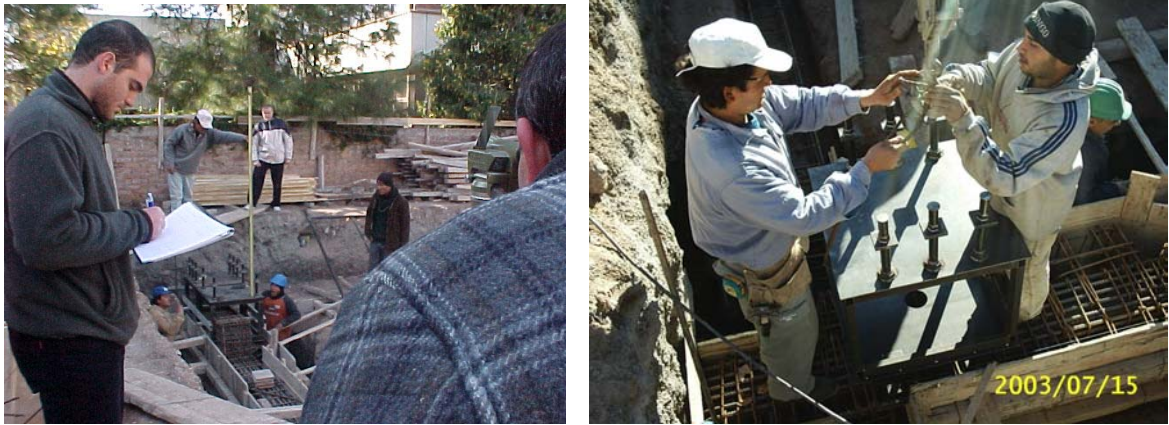
Fig. 9.5: Control en obra del posicionamiento del montaje de las platinas de anclaje del sistema de aislamiento
