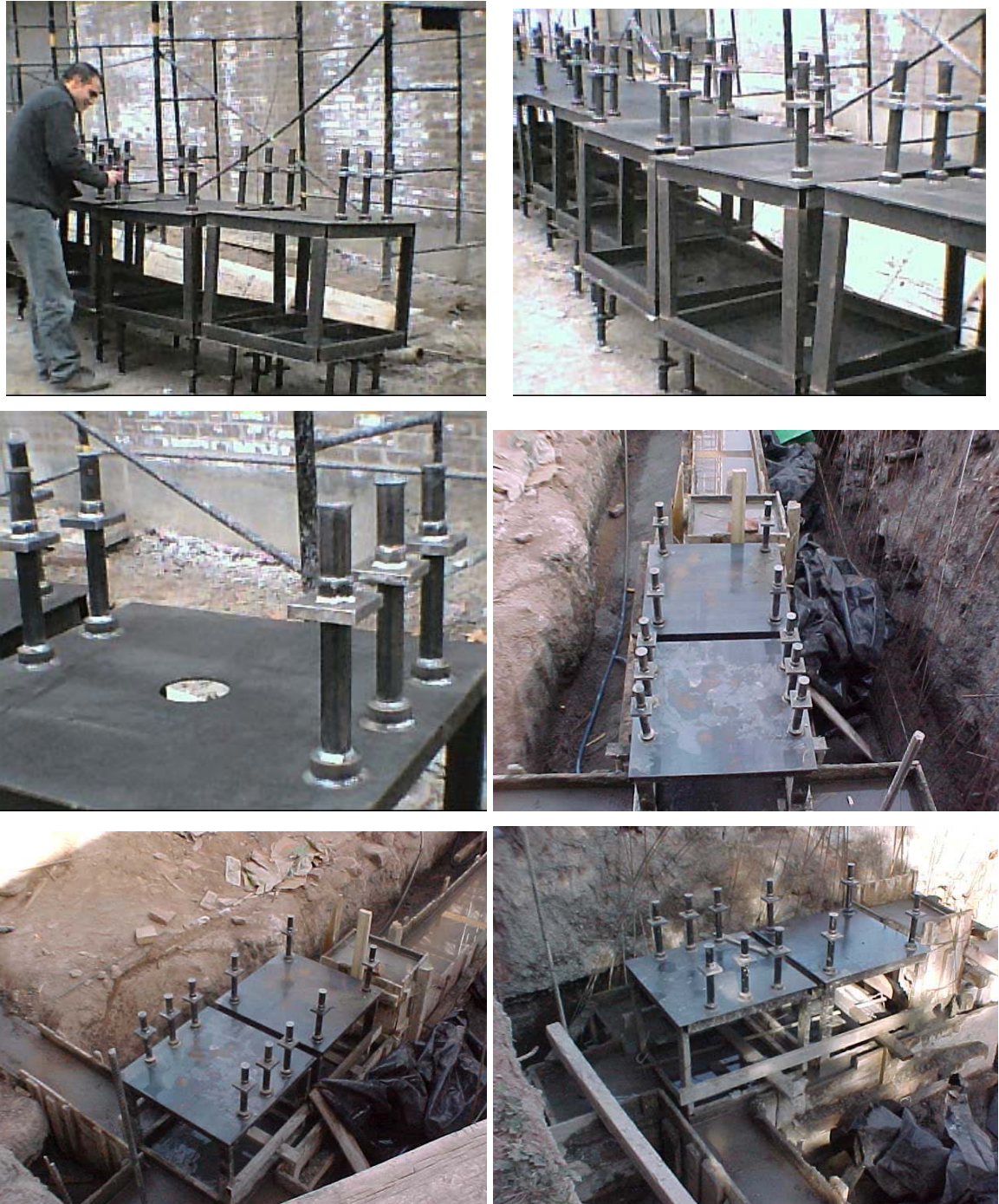
Fig. 9.4: Montaje de las platinas de anclaje del sistema de aislamiento
