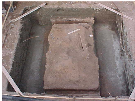
Fig. 9.1: Trabajos de excavación para alojar la estructura de fundación del edificio con aislamiento sísmico (Torre 3)
