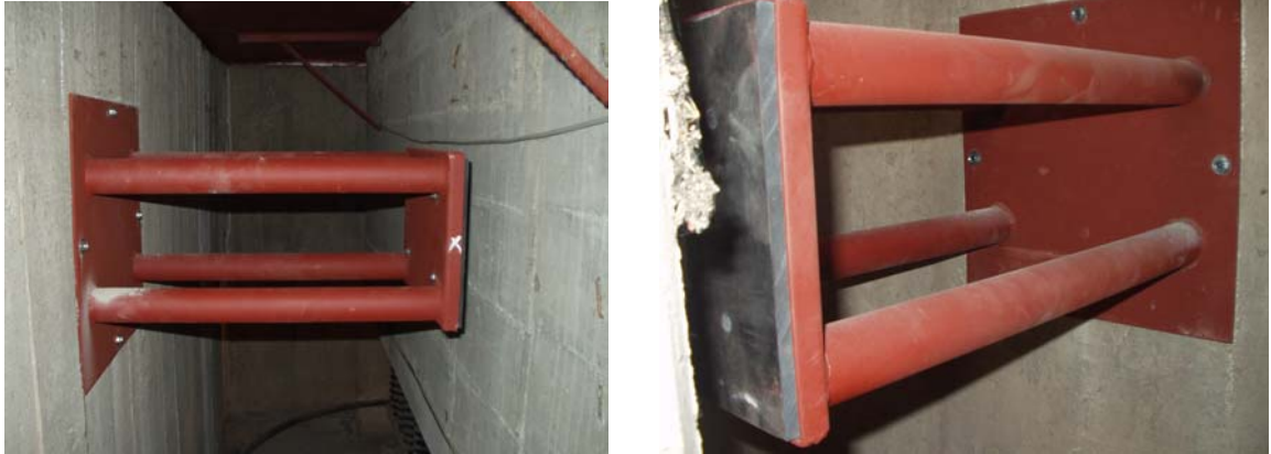
Fig. 9.19: Topes de control de desplazamientos horizontales del edificio con aislamiento sísmico.
