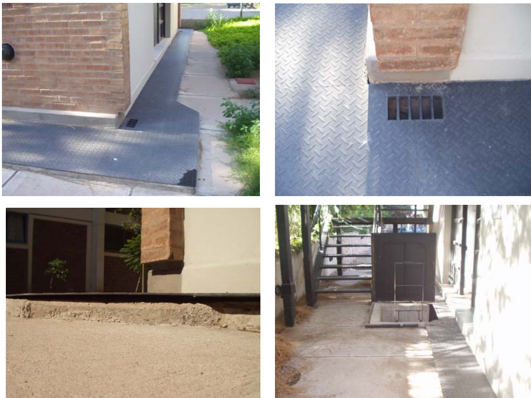
Fig. 9.18: Cerramiento de chapa reforzada entre el edificio y el tabique de hormigón armado del subsuelo.
