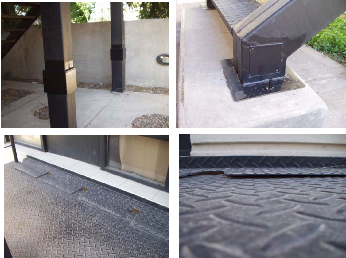
Fig. 9.17: Intervenciones post construcción realizadas en obra para desacoplar las escaleras del movimiento del edificio con aislamiento sísmico.
