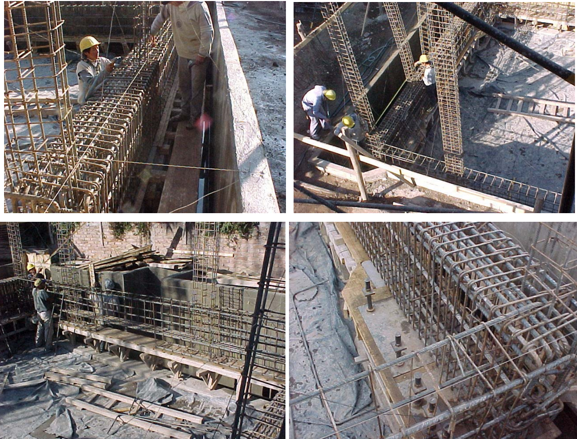
Fig. 9.9: Posicionamiento de las armaduras de las vigas y columnas por encima del sistema de aislamiento.
