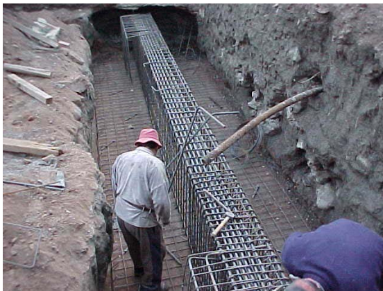
Fig. 9.2: Disposición de las armaduras de la bases corridas y vigas de fundación incorporadas
