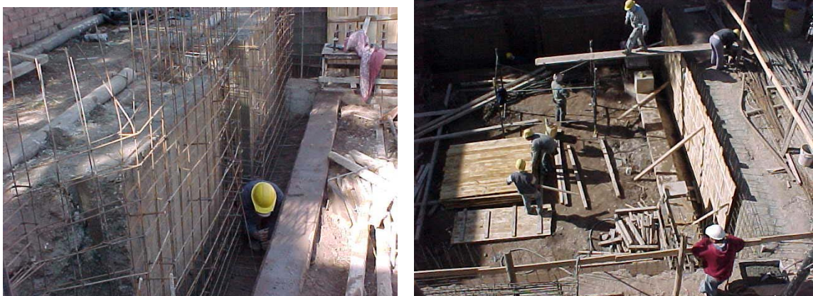
Fig. 9.6: Disposición de armaduras del tabique perimetral del subsuelo
