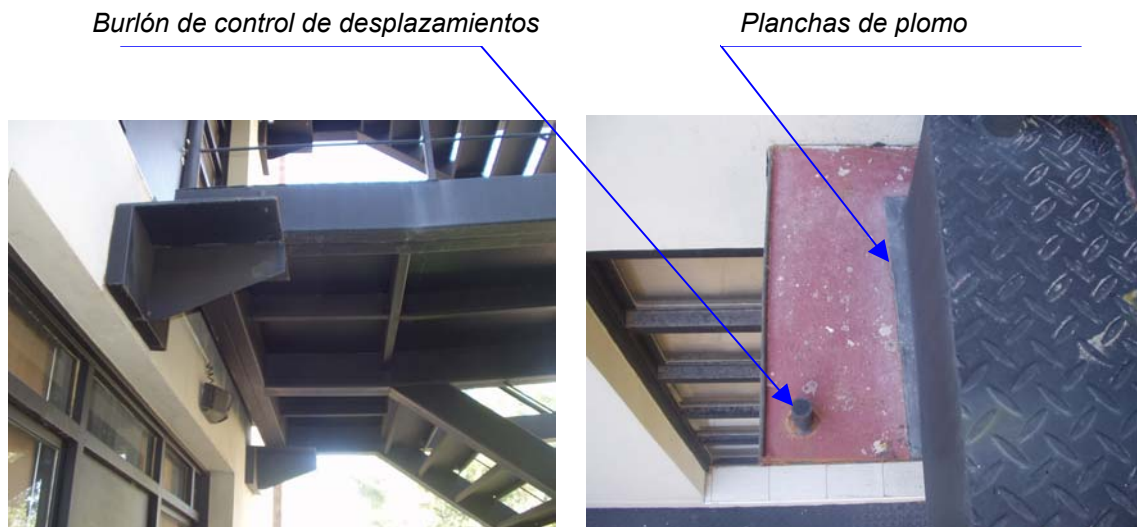
Fig. 9.16:Detalle de las ménsulas de apoyo de las escaleras metálicas en el encuentro del edificio con aislamiento sísmico
