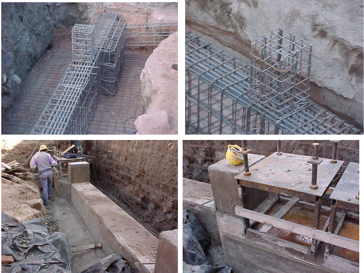
Fig. 9.3: Ubicación y armaduras del dado de hormigón armado donde se apoyaría la superestructura del edificio durante la etapa de construcción. Estructura de fundación hormigonada
