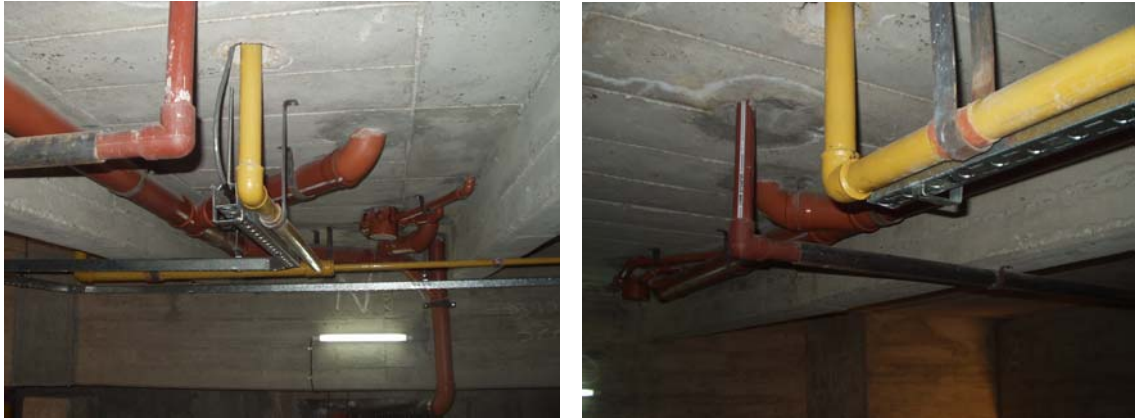
Fig. 9.12: Recorrido de las instalaciones de desagües primarios, secundarios, gas y agua a nivel de losa de planta baja (por encima del sistema de aislamiento)
