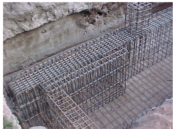
Fig. 9.2: Disposición de las armaduras de la bases corridas y vigas de fundación incorporadas
