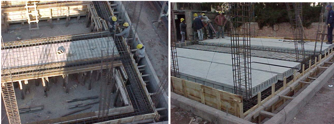
Fig. 9.10: Vigas, losas y columnas ubicadas inmediatamente por encima del sistema de aislamiento.
