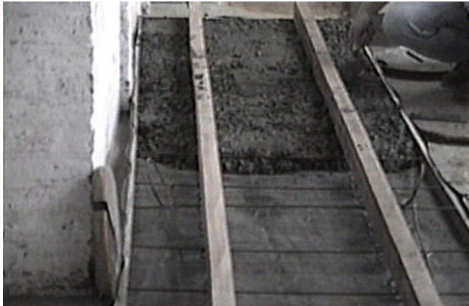
Figura 12: Hormigonado del prototipo
