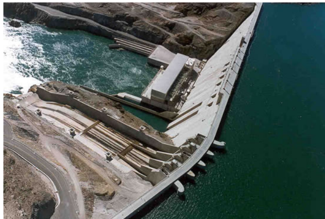
Fotografía N° 1: Vista General de la Presa Piedra del Águila
