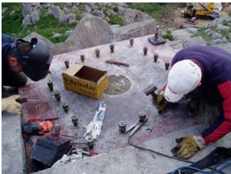
Figura 16: Placa de anclaje con bulones a la espera de la réplica
