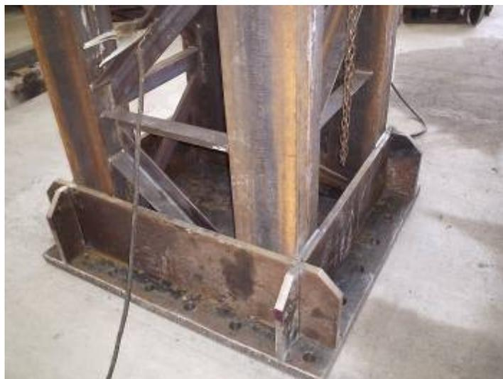
Figura 14: Detalle de columna en zona de unión con cartelas y placa base
