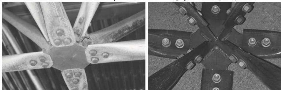
Figura 4: Ligação dos elementos com nó de aço (Vendrame, 1999)
