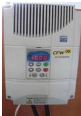
Figura 15: Inversor de frequência do motor elétrico
