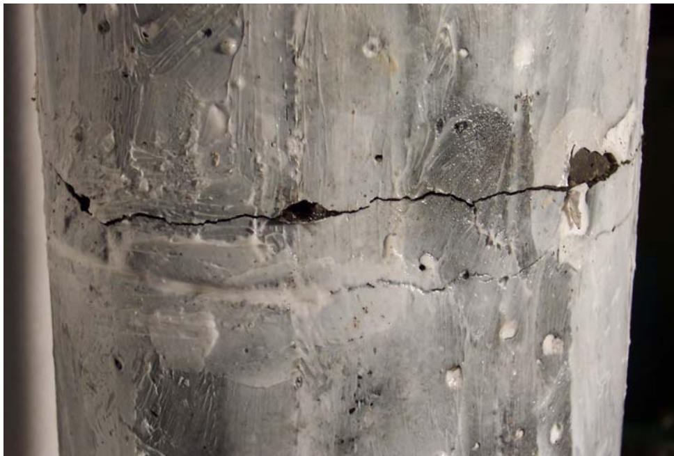
Figura 9. Planos potenciales de falla horizontal
