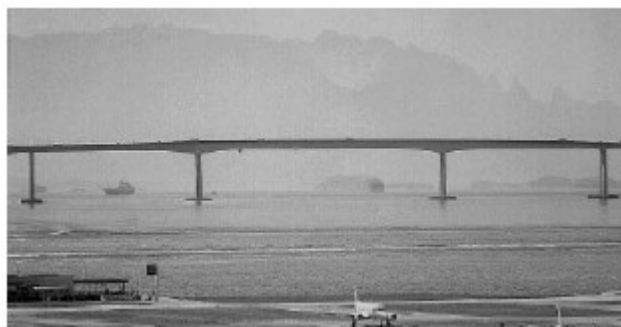
Figura 1: Vista da ponte pelo aeroporto Santos Dumont (Battista e Pfeil, 2000).
