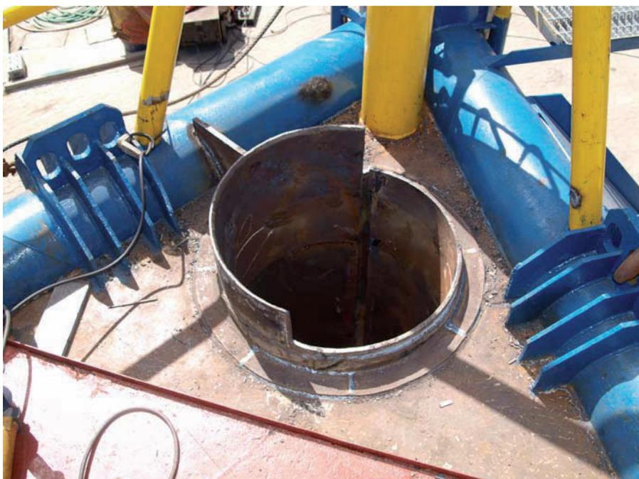
Fotografia 2 - Tubo-guia soldado na chapa de transmissão de forças horizontais, no convés da plataforma.
