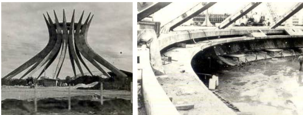
Figura 11: Estrutura dos pilares e detalhe da construção do anel de tração na base da Catedral de Brasília, 1959 Fonte: Arquivo Público do DF
