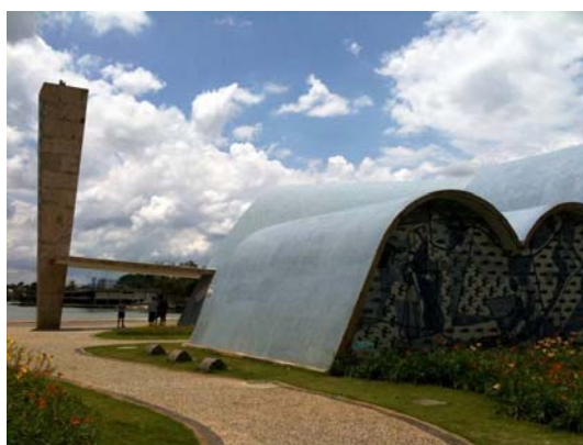
Figura 2: Igreja São Francisco de Assis na Pampulha, Belo Horizonte-MG. Foto do autor.
