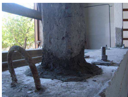
c) Mortero aplicado en la zona de base de columnas.
