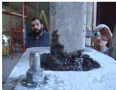
b) Adhesivo epoxi en zona de hormigón eliminado
