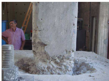
a) Hormigón eliminado en base de columnas.
