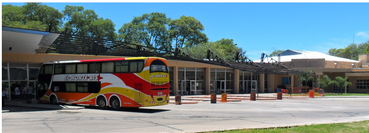
Figura 1: Vista de la cubierta dañada.
