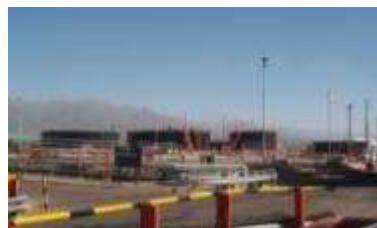
(b) Destilería YPF, Lujan de Cuyo, Mendoza
