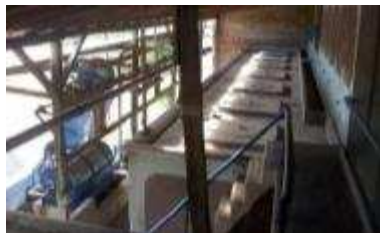
(c) Pileta de fermentación de bodega, San Rafael, Mendoza.
