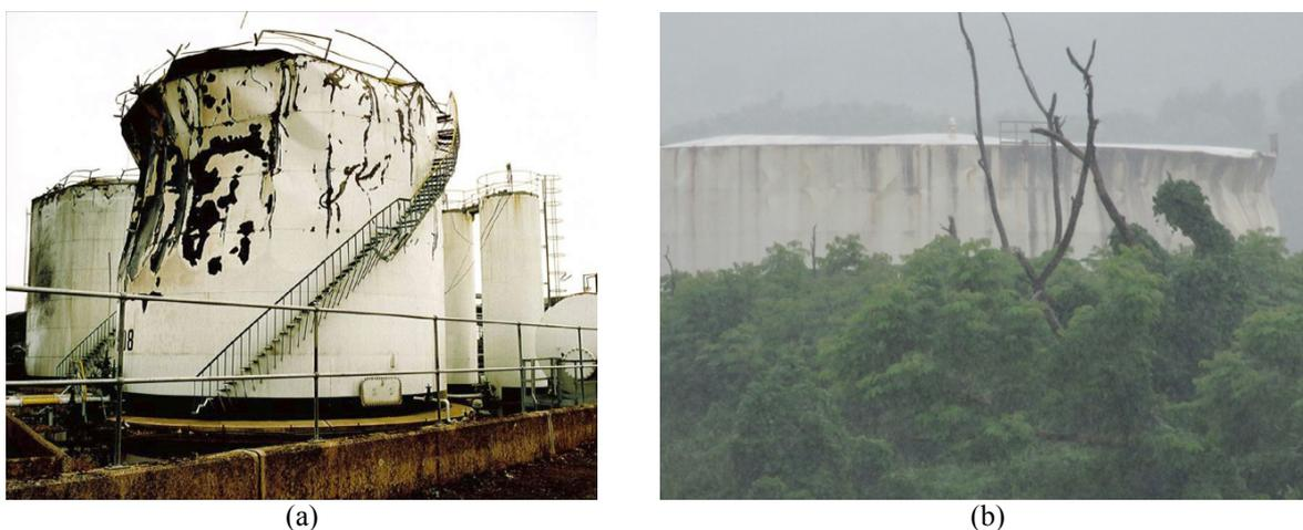
Figura 1: Daños en tanques de almacenamiento de combustibles debidos a explosiones. (a) Buncefield, UK, 2005; (b) Bayamón, Puerto Rico, 2009.
