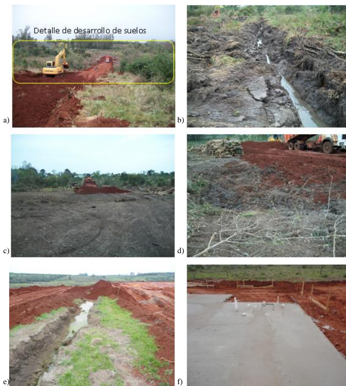
Figura 1: Registro fotográfico de un predio con presencia de suelo gris anegado, donde se detalla la secuencia constructiva para la ejecución de conjuntos habitacionales.
