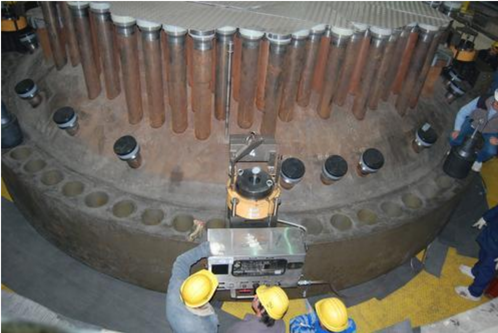
Figura 3 Recinto del Reactor: vista de los canales combustibles (fuente: http://www.na-sa.com.ar )
