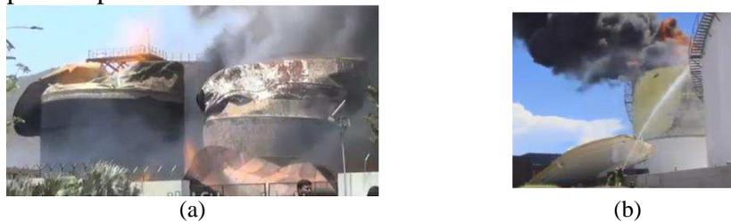
Figura 3: Tanques con Techo desprendido. (a) India 2016 y (b) Samoa 2016
