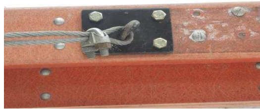
Figura 5: Detalle unión rienda – escalera
