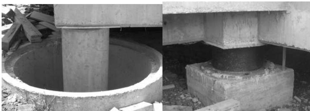
Figura 4: Sistema de aislamiento conformado por bielas de hormigón armado (PPP) y aislador elastomérico.
