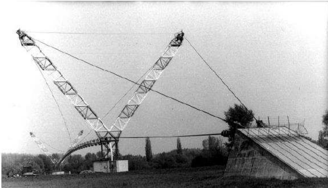
Figura 8: Puente de tubería a través del Río Danubio en Barbara.
