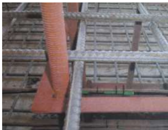
Figura 3: Termoclas adheridas a los insertos
