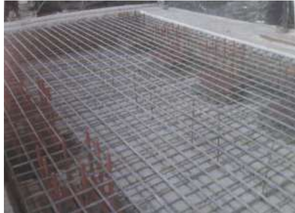
Figura 2: Armaduras e insertos en losa
