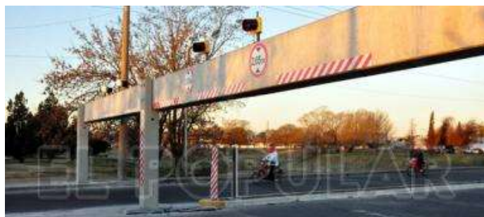
Figura 1: Vista general de la estructura del limitador colocada sobre el puente.
