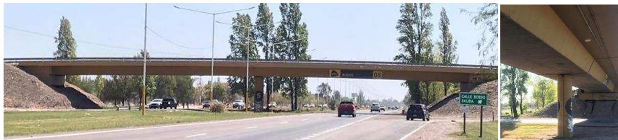
Figura 1: Puente de calle Boedo y RN40, provincia de Mendoza.
