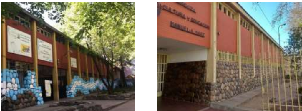
Figura 1: Fachadas de los establecimientos 1-106 (izquierda) y 1-207(derecha).
