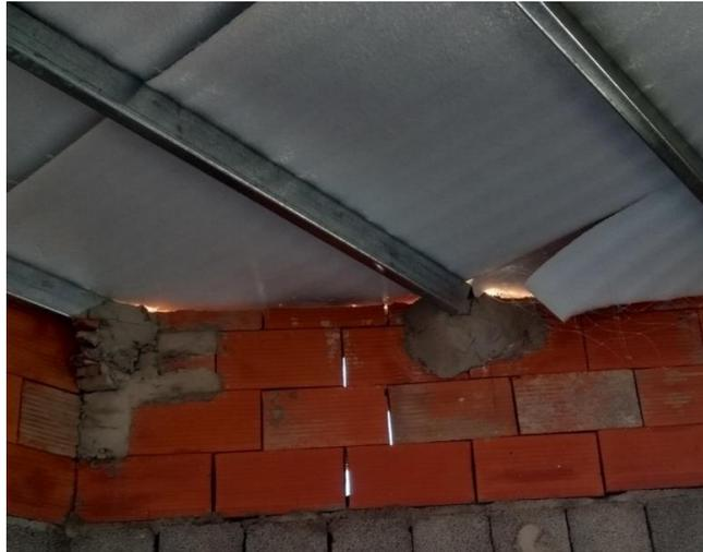
Figura 1: Materialización del apoyo en la pared sobre la línea municipal de un complejo de departamentos
