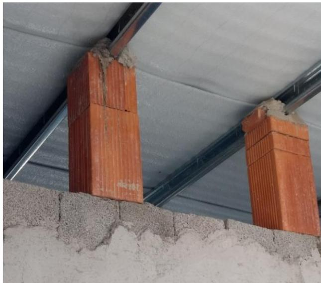
Figura 2: Materialización del apoyo en la pared interna de un complejo de departamentos
