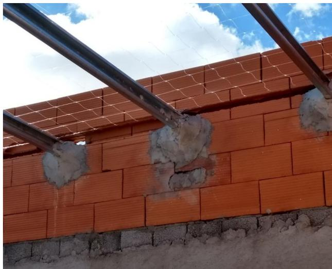
Figura 3: Materialización del apoyo en la pared medianera de un complejo de departamentos
