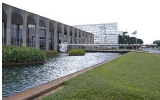
Figura 21: Fachada do Palácio do Itamaraty, Brasília. Foto do autor.
