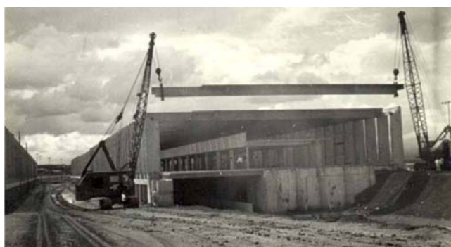
Figura 20: Montagem das vigas pré-moldadas da cobertura do ICC. Fonte: FONSECA, Regis, 2007, p. 6.
