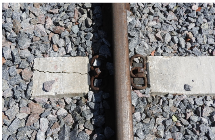
Figura 1: Fisuración longitudinal en durmiente de hormigón pretensado instalado en vía.
