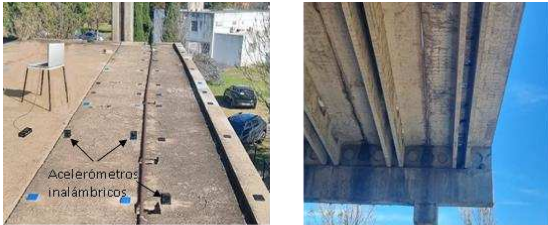
Figura 1: Vista superior e inferior de la viga pretensada prefabricada
